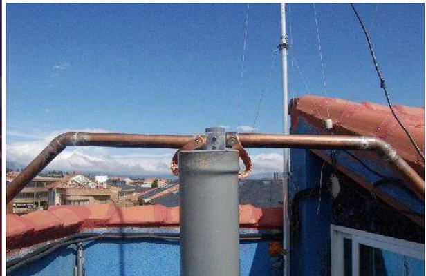
Según el programa-hoja de cálculo de AA5TB, este nuevo aro-octógono nos proporcionará, en teoría, un aumento de rendimiento de un 18% respecto al aro de forma circular que se construyó anteriormente con tubo de Ø18mm, situando la eficacia total en un 50% en 7.100KHz y en un 92% en 14.200KHz.
