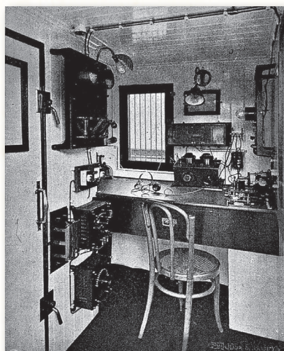
Estación Marconi de un vapor de la C a Trasatlántica. Aparatos receptor y parte de los transmisores
