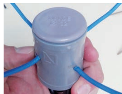
Imagen 32. Montaje acabado y tapado
