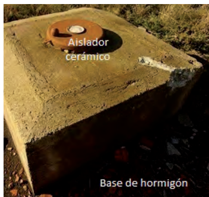
Imagen 2. Base sobre la que se asentaba la torre
