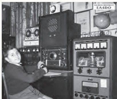
Isi, EA4-599.U, en 1957, ante el receptor National HRO-50 R (rack para el juego de bobinas intercambiables) de la estación EA4DO. A la izquierda "El tres de bastos" y a la derecha "La Pintora", transmisores contruidos ambos por EA4DY.
